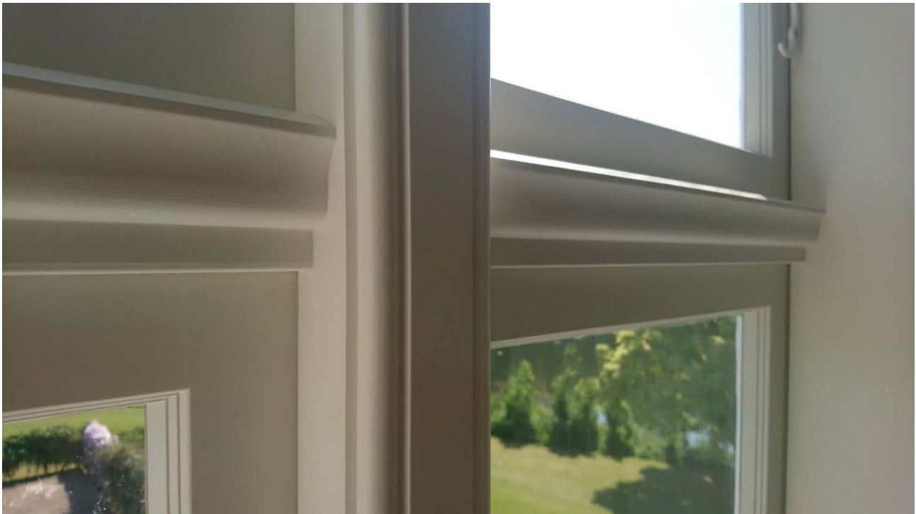
Perlestaff-profil på lodpost og svanebalsprofil på tværpøst
