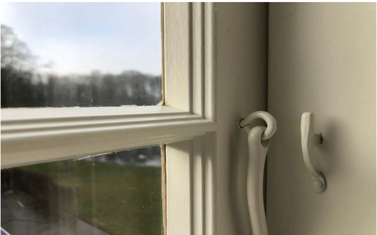
Specialprofilering af sprosser og ramme
